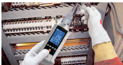
Contrôle des différentiels avec le Catex™ NG DT-170 muni du cordon pour intervention sur tableau (Réf. M-952271).
