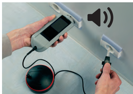
Contrôle de la continuité sur prise 2P+T avec le Catohm™ NG (Réf. DT-300) équipé de sa pointe de touche sur enrouleur.
