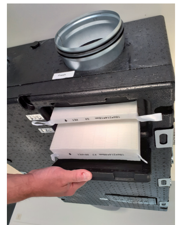
Accessibilité des filtres pour entretien
