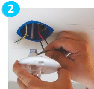
2 Câblage du socle et du micro module
