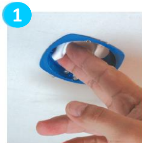
1 Mise en place du boîtier dans le faux-plafond
