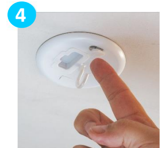
4 Finition : mise en place des caches de tête de vis
