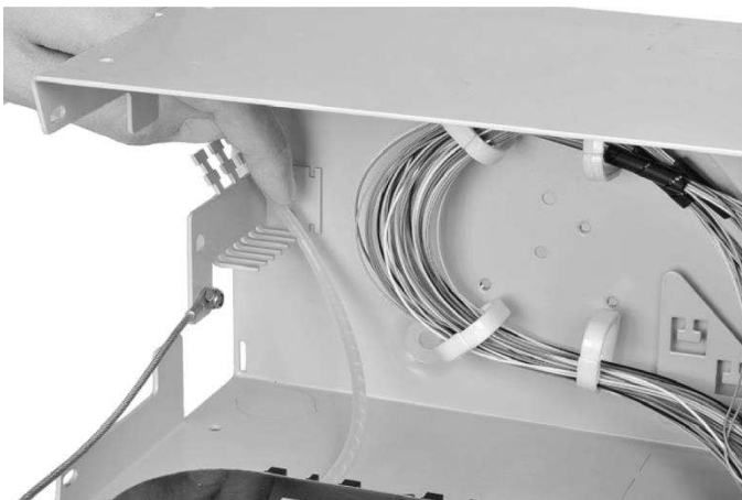
4.4 Mesurer le tube spiral entre le support et la cassette, et le couper. Poser du ruban isolant sur les deux extrémités.
