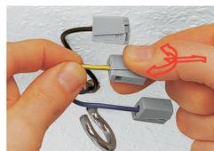
Raccordement du conducteur : introduire le conducteur rigide dénudé dans l'ouverture ronde jusqu'au fond.
